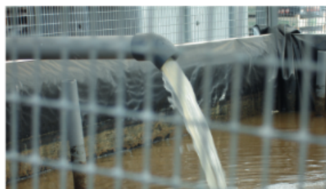
Entrada del agua residual en el depósito.
